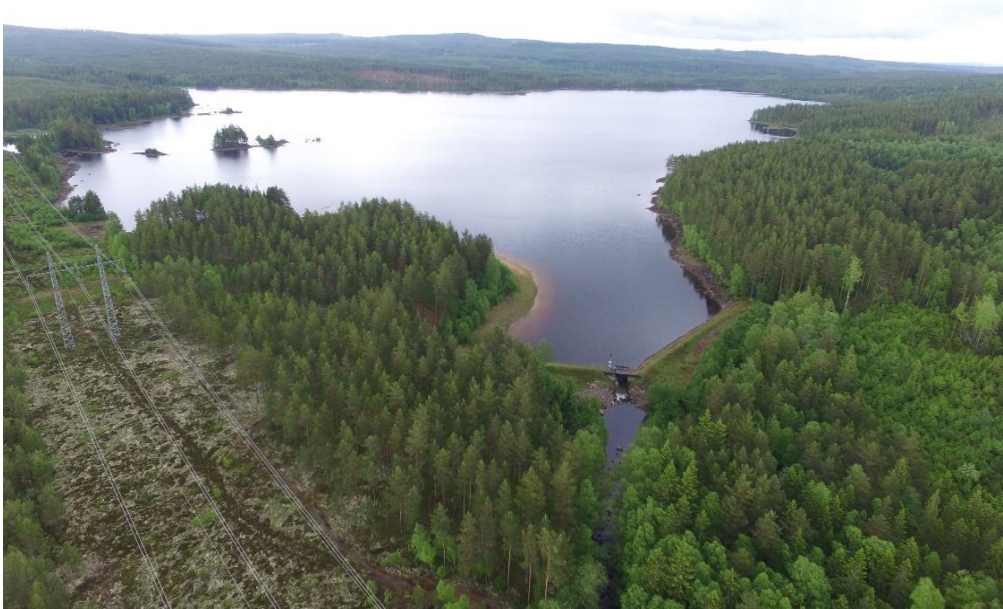
Foto 1 Acksjön före utrivning, sommar 2016. foto Axel Emanuelsson, Norconsult
