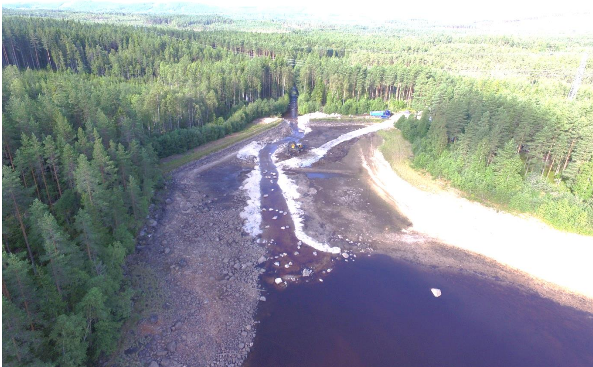
Foto 6 Utloppsviken under arbete, arbetsvägen och maskinen syns. Sjön ligger någon dm under den nivå som utloppet konstrueras för. Foto Axel Emanuelsson, Norconsult
