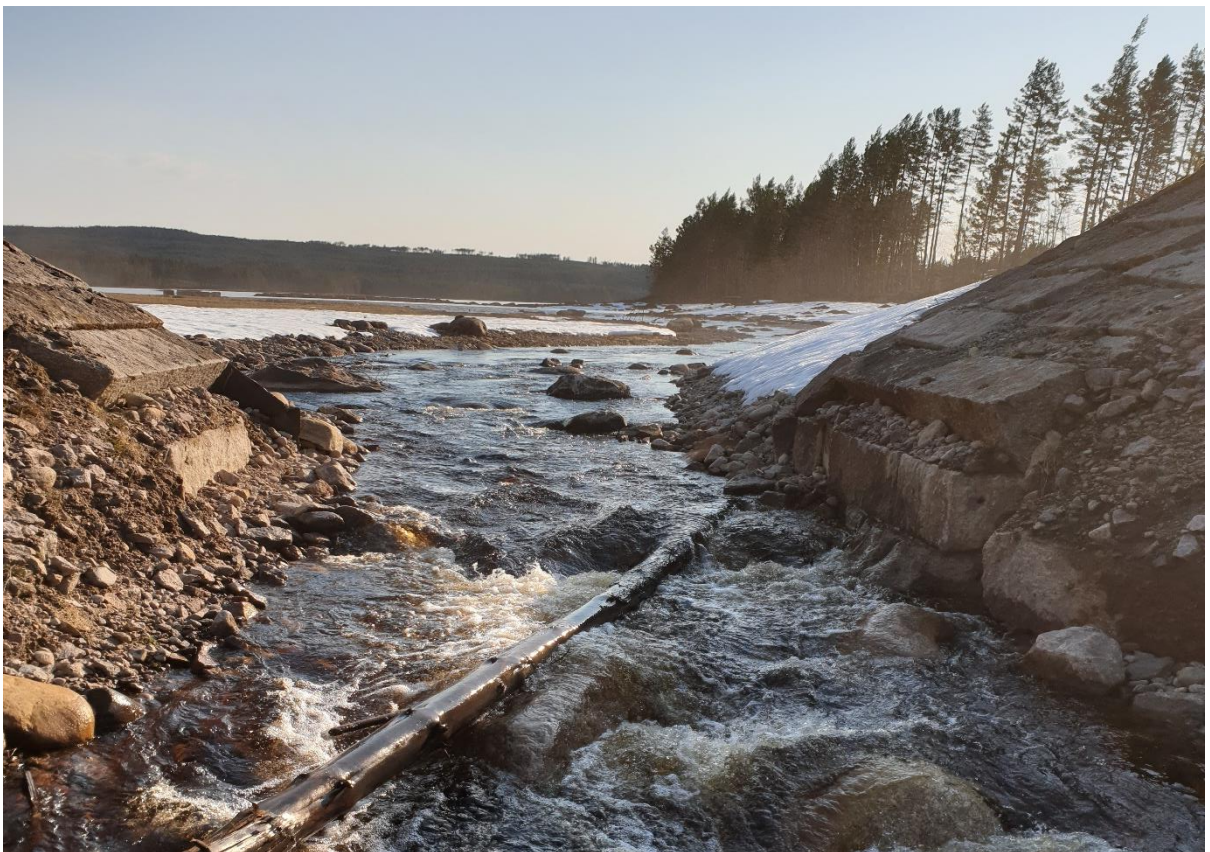
Foto 8 Acksjödammen efter utrivningsarbetet 2019-04-10 Foto A Sjörs
