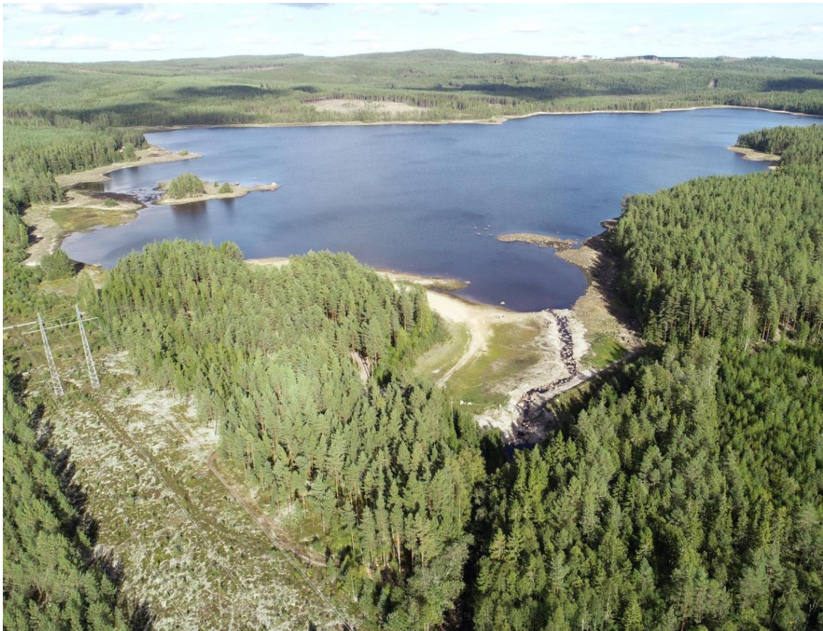
Foto 3 1 år efter utrivning, 2018-09-13. Sjöns nivå har under sommaren legat något under sin nya tröskel på grund av den svåra torkan. Foto A. Emanuelsson, Norconsult.
