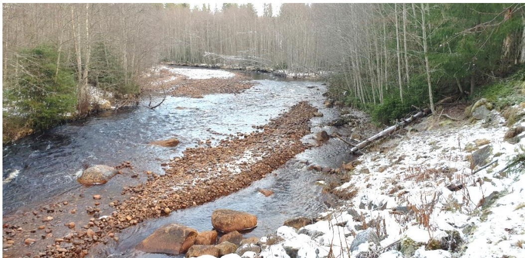
Foto Strax uppströms tidigare Trandamm.
