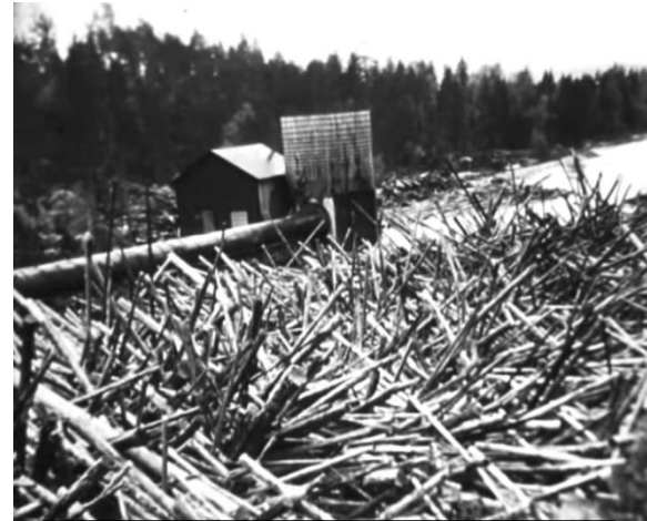
Foto på timmerbröt vid nedströms dammen vid Klar-Persfallet kring 1950, kraftverk och tub syns. Se även sid 35
