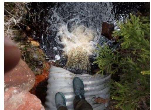
Förslag på åtgärd Byt ut trumman
