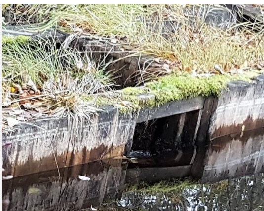
Kvarntjärnsdammen före och efter: Träkonstruktionen har tagits bort och älvsträcken nedströms har byggts upp med block och stenar.
