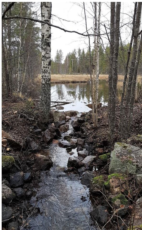
Efter åtgärd: block/stenar ligger i bäcken och bygger upp nivån.
