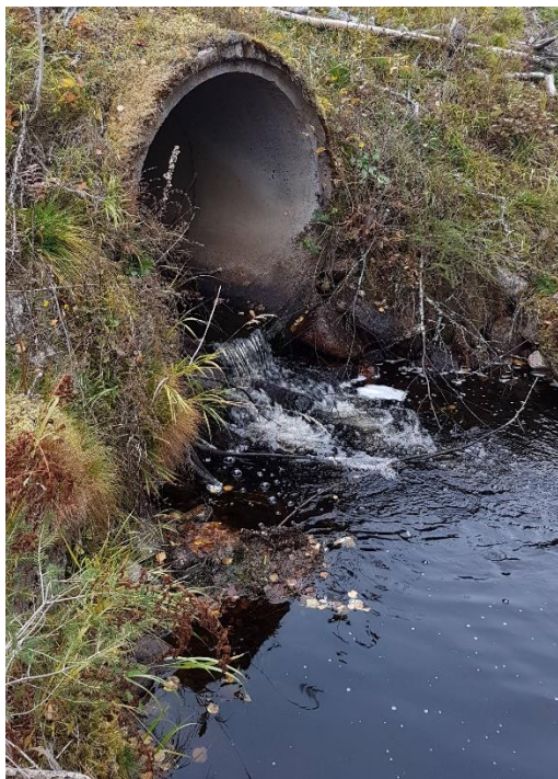
Trumman läge före åtgärd, foto vid normal vattenföring
