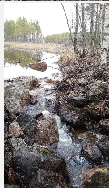
Kvarntjärnsdammen före och efter: Träkonstruktionen har tagits bort och älvsträcken nedströms har byggts upp med block och stenar.
