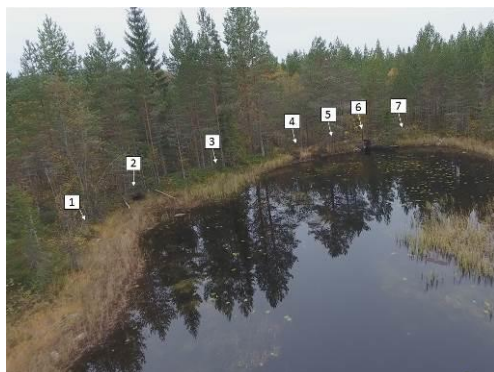
Figur 6. Ormräjtikas reglerdamm sedd från uppströmssidan. Norconsult 2016-10-13.
