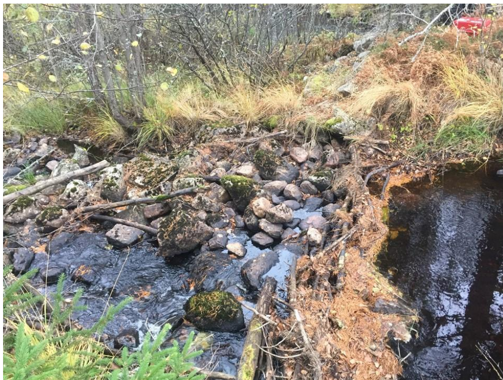
Figur 14. Öppningen i dammen där fiskvandring möjliggörs ifall vattenytan höjs så att flödet ökar. Norconsult 2016-10-13.
