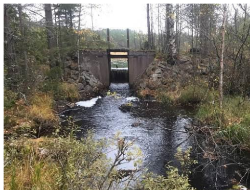
Figur 7. Ormräjtikas utskovsdelar (6) sedd från nedströmssidan. Norconsult 2016-10-13.
