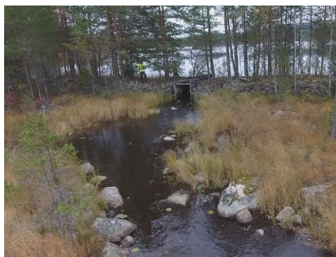
Figur 9. Ögsjöns reglerdamm sedd från nedströmssidan. Norconsult 2016-10-13.
