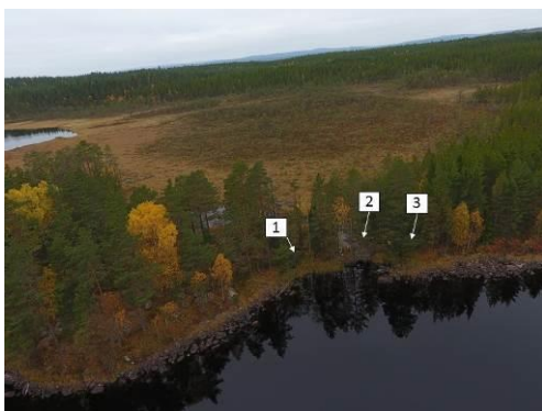
Figur 8. Ögsjöns reglerdamm sedd från uppströmssidan. Norconsult 2016-10-13.
