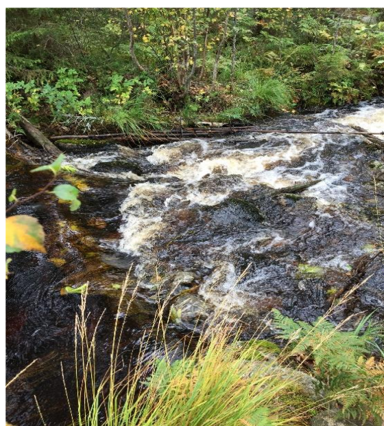
Dammbrottet låga flöden
