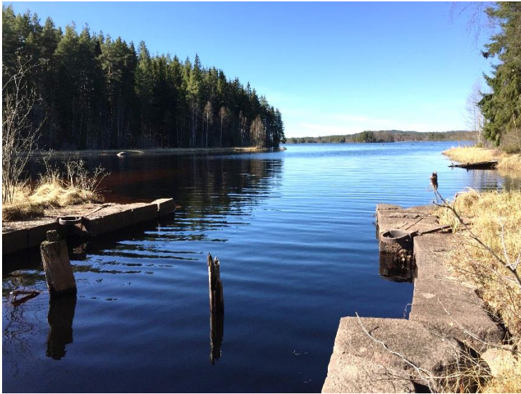
Ovan och t.v. Slussen, foto mot Deglunden
