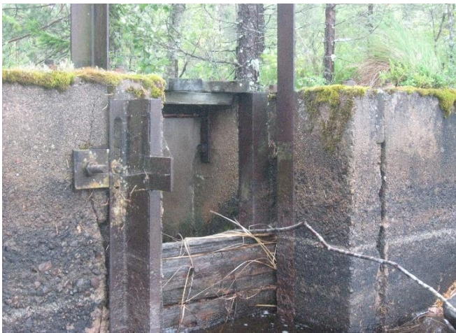
2010 Dammen håller inte lägre sjön, sjöns nivå antecknad till + 10 cm. Sättare upp till nivå 40 cm, dammen läcker.
