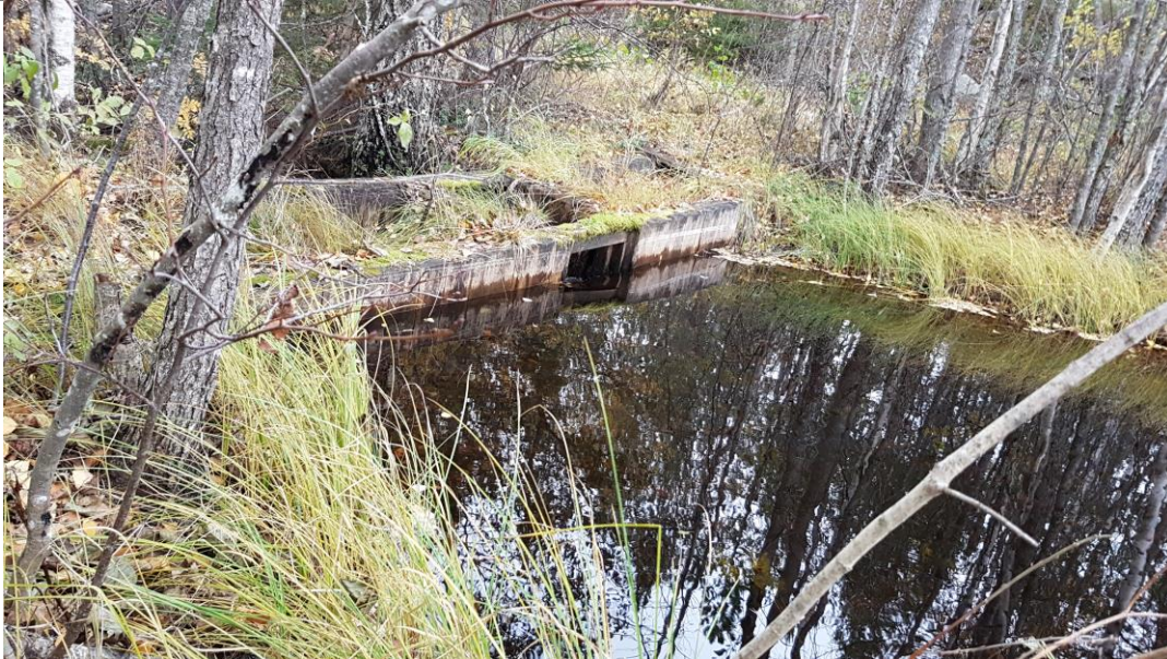
Foto från vägen upp mot dammen samt på trumma under väg. Trumman inget vandringshinder.
