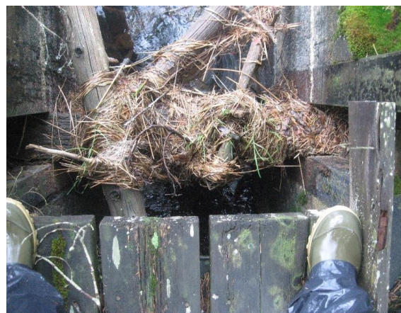
Bråte i ut-skovet, litet läckage
