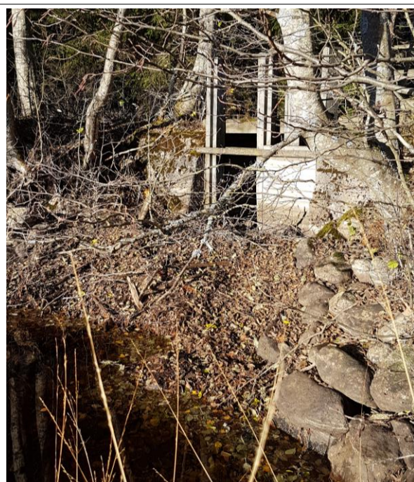
Motsvarande foto från okt 2016 med mycket låga flöden, som visar att allt vatten går över "dammbrottet" vilket möjliggör en vandringsväg. Utskovets botten ligger någon dm över sjöytan, inget vatten går här. (nedre bilden t.h.)
