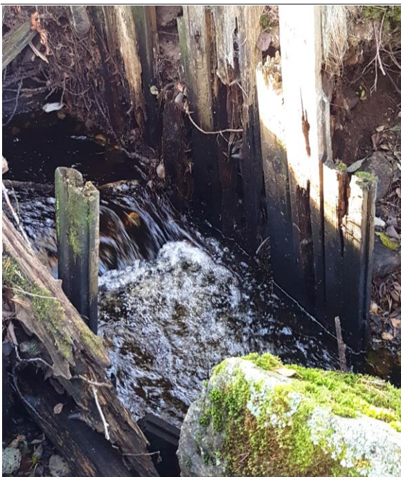
Motsvarande foto från okt 2016 med mycket låga flöden, som visar att allt vatten går över "dammbrottet" vilket möjliggör en vandringsväg. Utskovets botten ligger någon dm över sjöytan, inget vatten går här. (nedre bilden t.h.)
