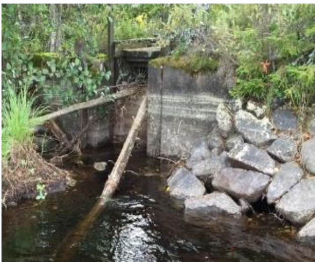
2015: nivå c: a 0,5 m. Sättarna håller inte nivån.
