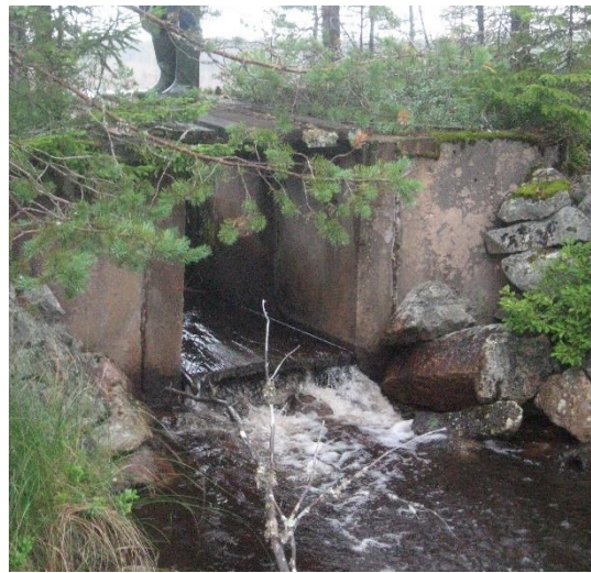
2010 Dammen håller inte lägre sjön, sjöns nivå antecknad till + 10 cm. Sättare upp till nivå 40 cm, dammen läcker.
