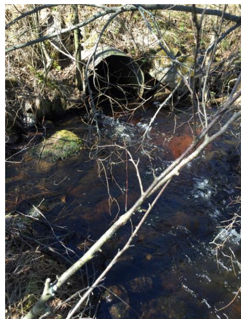
Foto från vägen upp mot dammen samt på trumma under väg. Trumman inget vandringshinder.
