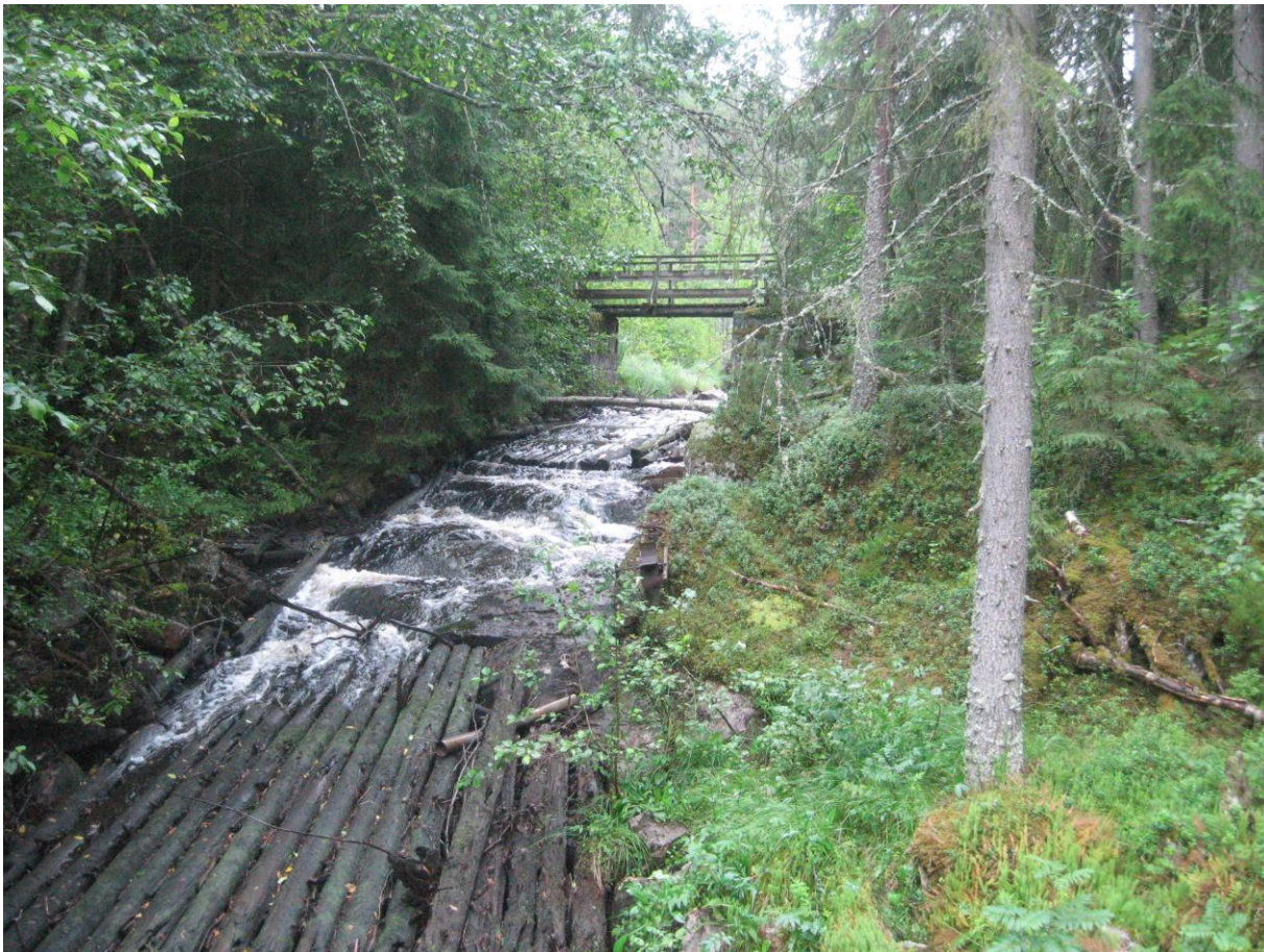
Sågåsen, timmerbeklädan över forsén för att underlätta flottning, foto sommaren 2010
