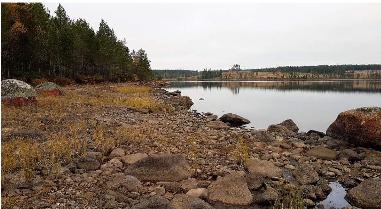
Älgsjön har successivt återgått till sin ursprungliga nivå pga läckande damm. Foto hösten 2016
