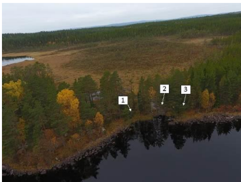
Figur 8. Ögsjöns reglerdamm sedd från uppströmssidan. Norconsult 2016-10-13.
