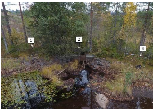
Figur 4. Lankans reglerdamm sedd från uppströmssidan. Norconsult 2016-10-13.
