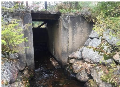
Figur 5. Lankans reglerdamm sedd från nedströmssidan. Norconsult 2016-10-13.
