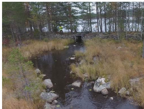
Figur 9. Ögsjöns reglerdamm sedd från nedströmssidan. Norconsult 2016-10-13.
