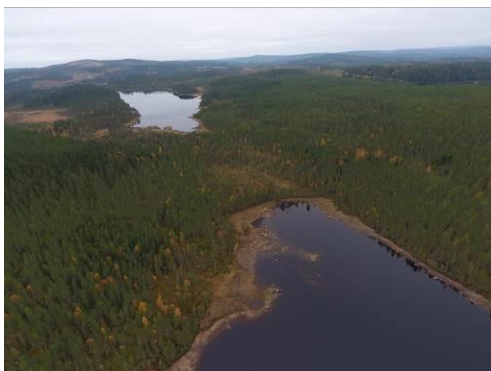
Figur 2. Älgsjöns reglerdamm och delar av Älgsjön sedd från uppströmssidan. Längre bort i bild syns även Lankan. Norconsult 2016-10-13.
