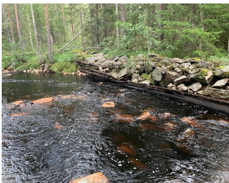
Foto på dubbelkista som vallar in den nya sträckningen. Längre nedströms
