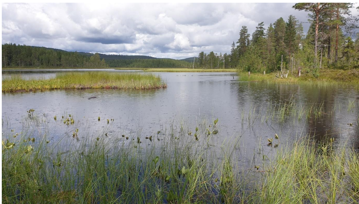
Flaten uppströms dammet från östra landvallen, högt vattenstånd 14 juli 2023.
