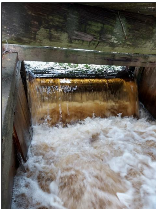
Utskov idag med sättar, Dammen verkar inte ha använts sedan 60-talet då man slutade med flottningen. Flygfoto från den tiden visar flottning
