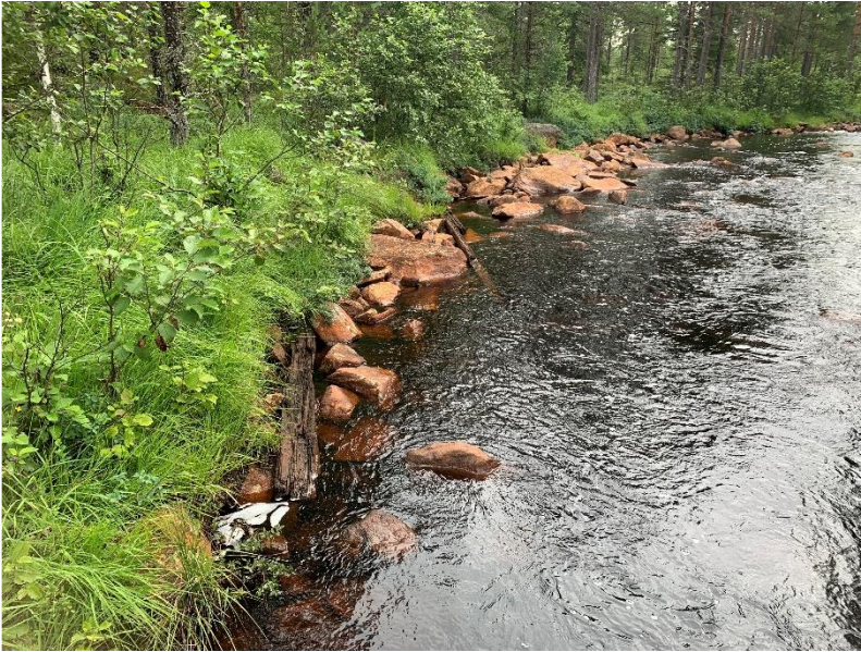
Sträcka 11 avslutas strax uppströms denna dubbelkista.
