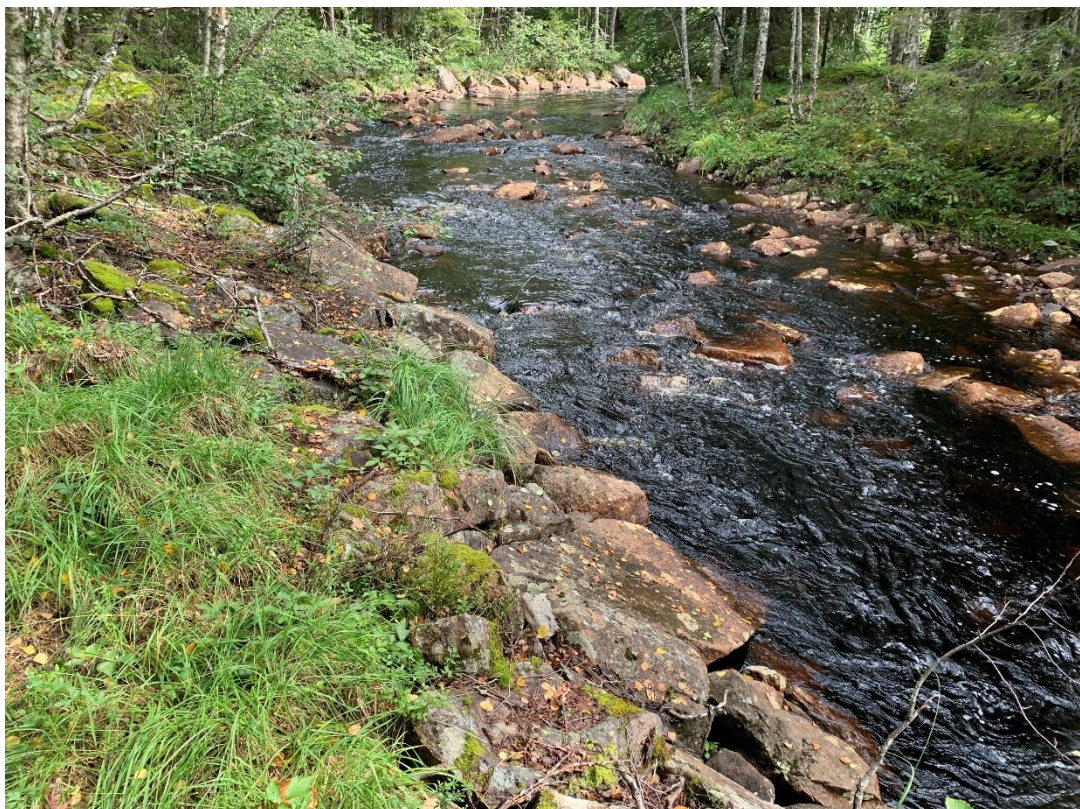
Sträckan är invallad med stora kantställda block
