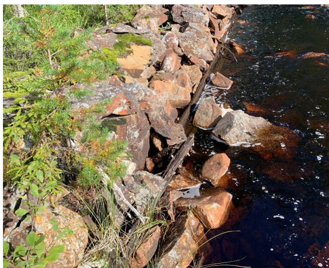
Sträcka 4 avslut strax uppströms lugnvattnet – sprängd sten som kan återföras bäcken.
