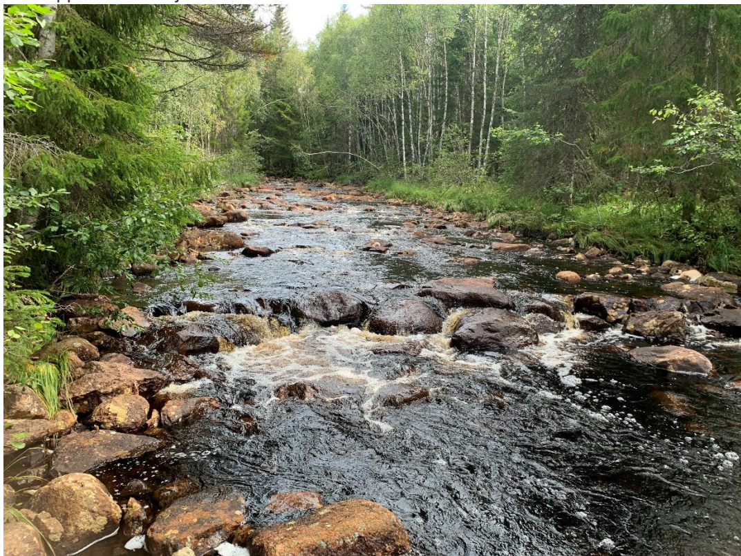
Sträckan är invallad med stora kantställda block
