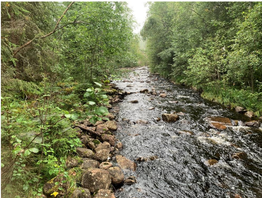
En bit uppströms. Våldiga rensvallar stängde av tidigare sidofårur ut i Halgån.
