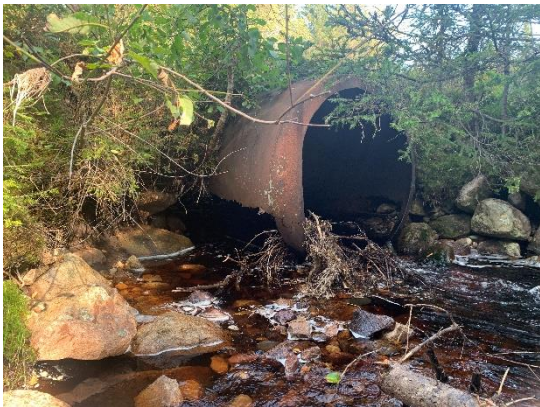
Sträcka 12 Trumma – erosion har skett bredvid trumman och vägen är på väg att rasera. Sista sträckan 15– vattnet rinner genom torvmark
