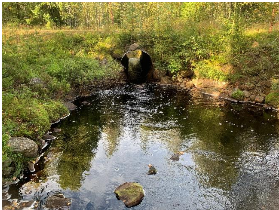
Sträcka 3 trummans lutning utgör hinder. Kraftigt rensat nedströms. övrigt, försiktigt rensad
