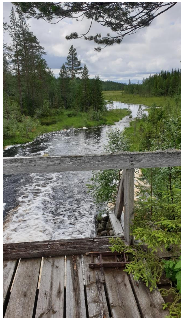
Nedströms dammet, ner mot våtmarken som tidigare dämdes upp av Stockholmsdammet
