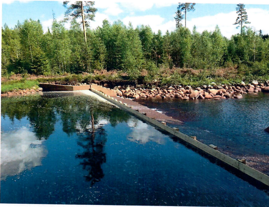
Foto 4 Veldig låga flöden aug 2013, Pil visar läcka vid vänster ledmur vid tröskeldammen
