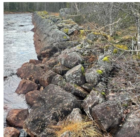
Plats där det är lämpligt att släppa in vatten bakom släntmuren
