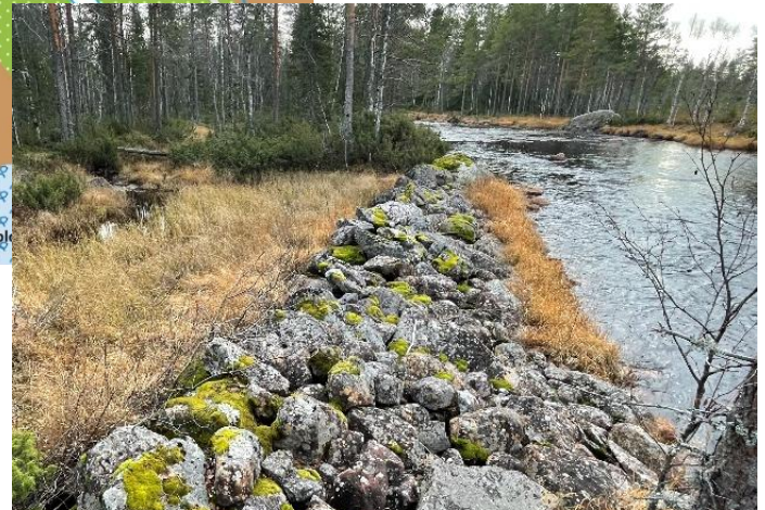
Släntande rensvall, inga synligt träkonstruktioner
