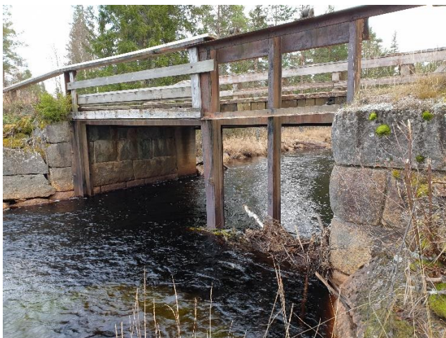
Foto på rester av dammkonstruktionen vid Flåen t.v., nedre Brunnbergsbron
