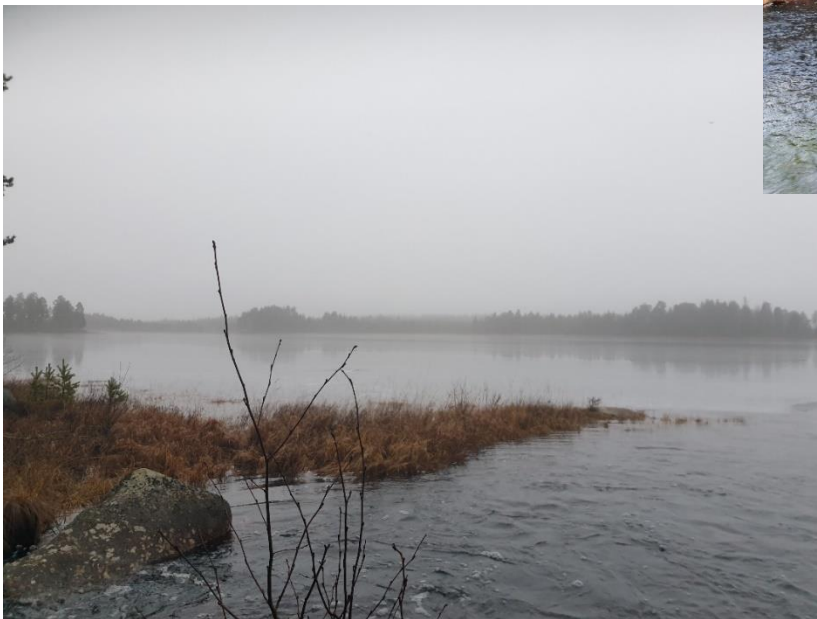
Foto på rester av dammkonstruktionen vid Tönnet-Flåen, nedre Brunnsbron. Bron har idag en dämmande effekt och vid höga flöden översvämmas Flåen Foto från 20 nov 2019.
