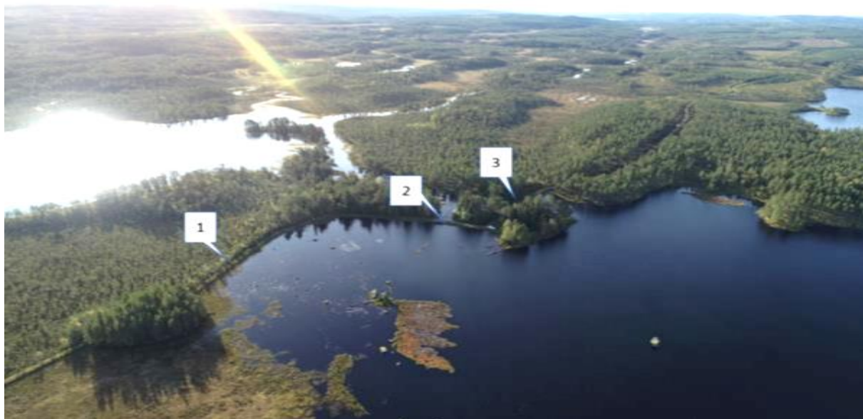
Mussjöns reglerdamm och del av Mussjön sedd från uppströmssidan. Till vänster i bilden syns även Sågtjärn. Foto Axel Emanuelsson, Norconsult 2019-09-17
