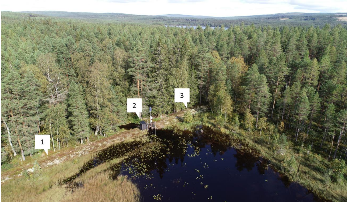
Ämtens reglerdamm och del av Ämten sedd från uppströmssidan. I bakgrunden skymtas Nordsjön. Foto Axel Emanuelsson, Norconsult 2019-09-17.
