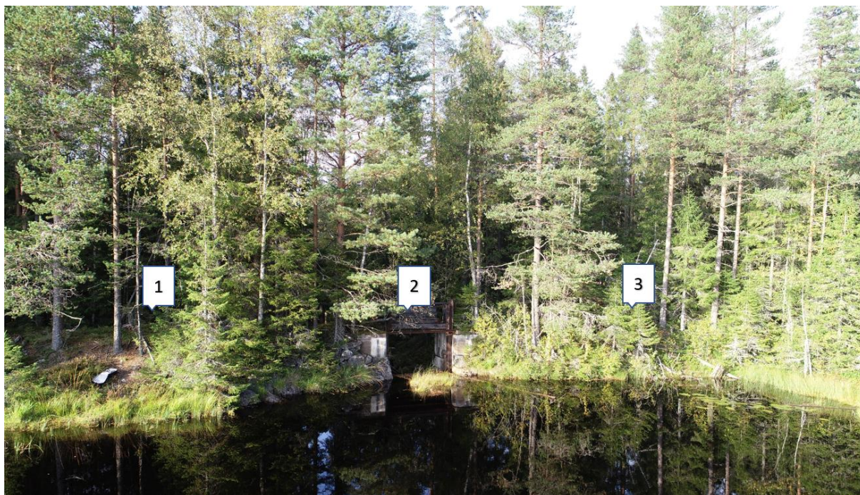
Rumpsjöns reglerdamm sedd från uppströmssidan Foto Axel Emanuelsson Norconsult 2019-09-17
