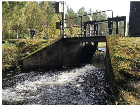
Figur 6. Ämtens reglerdamm sedd från nedströmssidan. Norconsult 2019-09-17.
