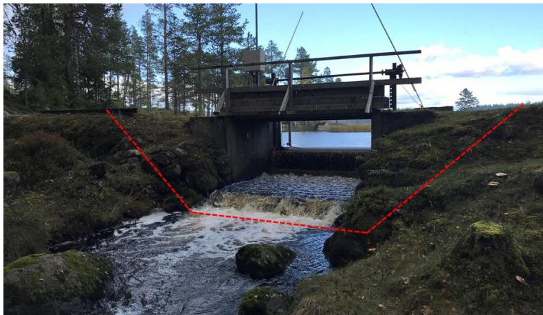
Figur 17. Kvarnsjöns reglerdamm med delar som rivs ut markerade
