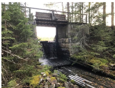
Figur 15. Rumpsjöns reglerdamm sedd från nedströmssidan. Norconsult 2019-09-17.
