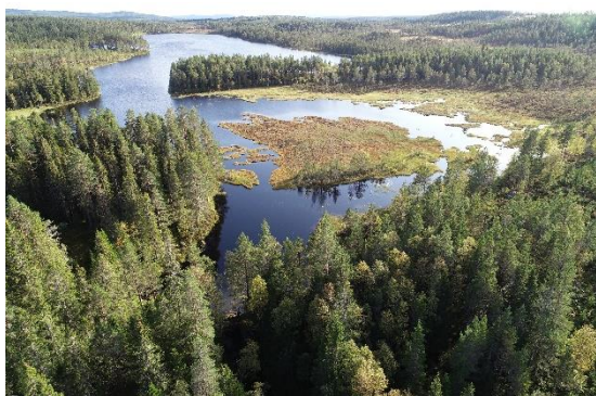
Figur 14. Rumpsjöns reglerdamm och delar av Rumpsjön sedd från nedströmssidan. Norconsult 2019-09-17.
