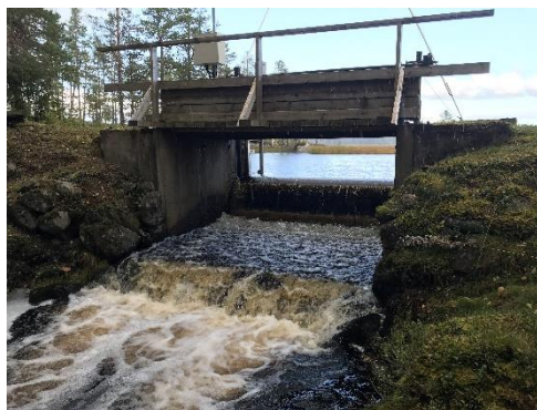
Figur 3. Kvarnsjöns reglerdamm sedd från nedströmssidan. Norconsult 2019-09-17.
