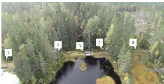
Figur 4. Kvarnsjöns reglerdamm och del av Kvarnsjön sedd från uppströmssidan. Norconsult 2019-09-17.
