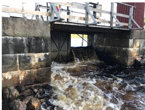
Figur 10. Mussjöns reglerdamm sedd från nedströmssidan. Norconsult 2019-09-17.
