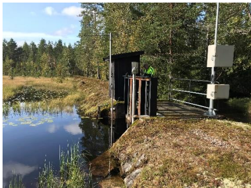
Figur 5. Ämtens reglerdamm och del av Ämten sedd från sidan. Norconsult 2019-09-17.
