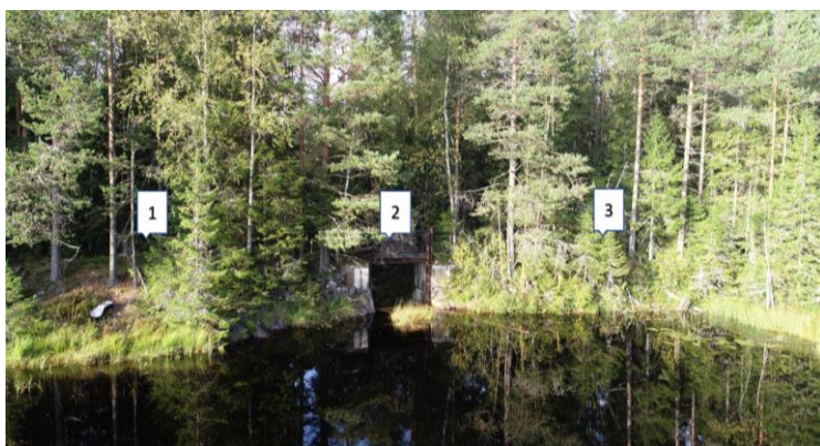
Figur 16. Rumpsjöns reglerdamm och del av Rumpsjön sedd från uppströmssidan. Norconsult 2019-09-17.
