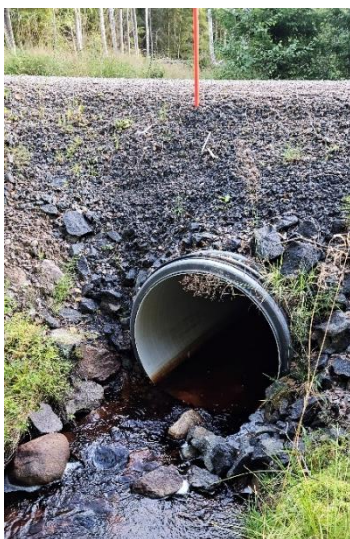
c. Borksjöbergbäcken Krossmaterial i trummans öppning
