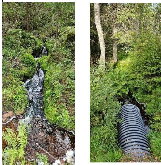
d. Borktjärnbäcken brant liten bäck, trumma lång
