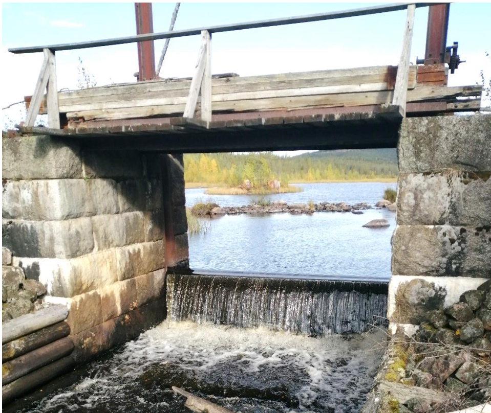
Rattsjödammen den 16 sept 2020. Dammen regleras i dag inte. Fast utskov c:a 0,5 m Uppströms syns en gammal stenvall som idag håller nivån i S Rattsjön
