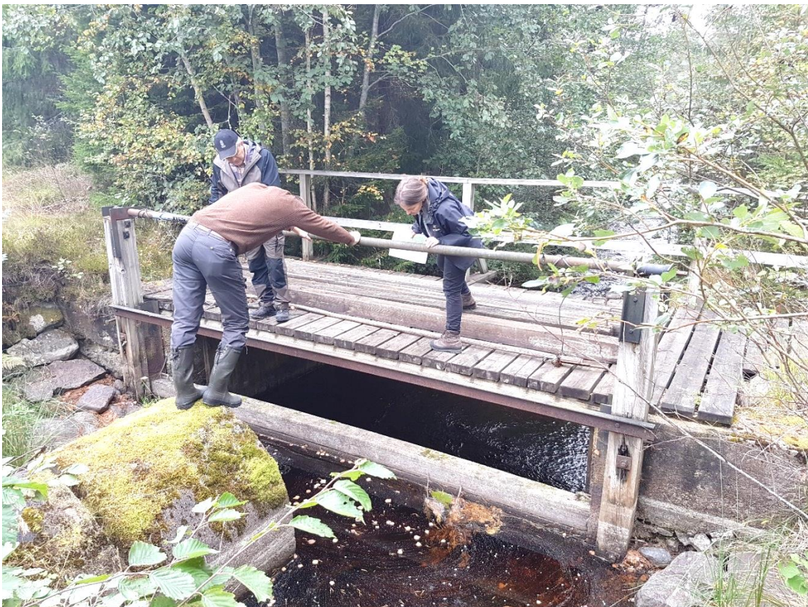
Flottningsutskovet, idag inget vandringshinder, vattnet går under sättnarna, samma nivå alltså, det syns dålig.
