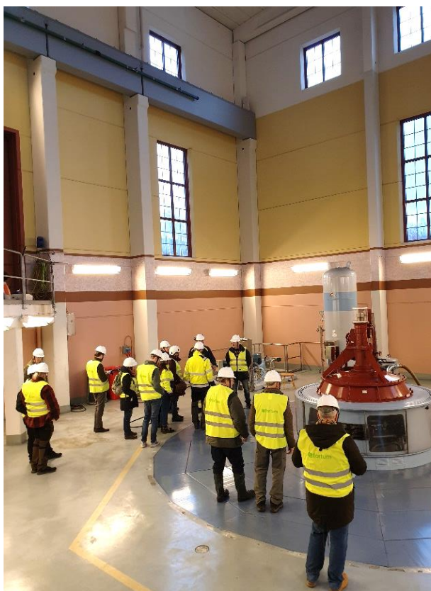
Foto 1 Fortum guidar runt på anrika Munkfors kraftverk
